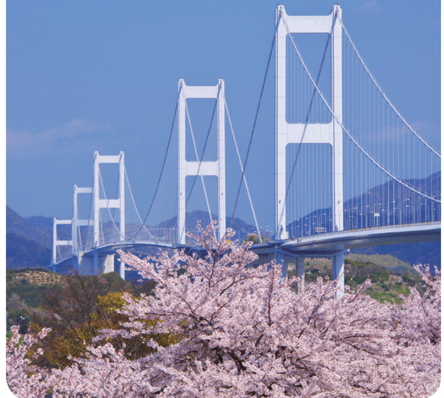
来島海峡大橋 (愛媛県)
